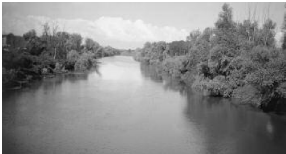
Fig. 5 - Il Po immediatamente a monte della briglia (vedi fig. 6) per la protezione idraulica del ponte di Casalgrasso (CN): lo sbarramento attenua la velocità del flusso idrico, determinando una notevole alterazione delle condizioni morfoidrauliche (foto G.B.D., 02.06.2006).
