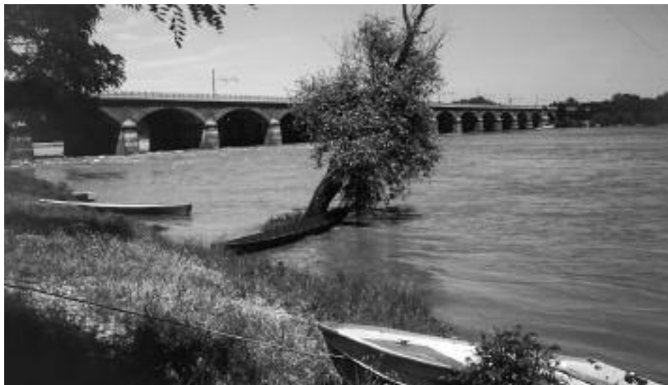
Fig. 10 - Fiume Po presso il ponte di Valenza (AL), nell'estremo Piemonte orientale (foto G.B.D., 19.06.1991).
