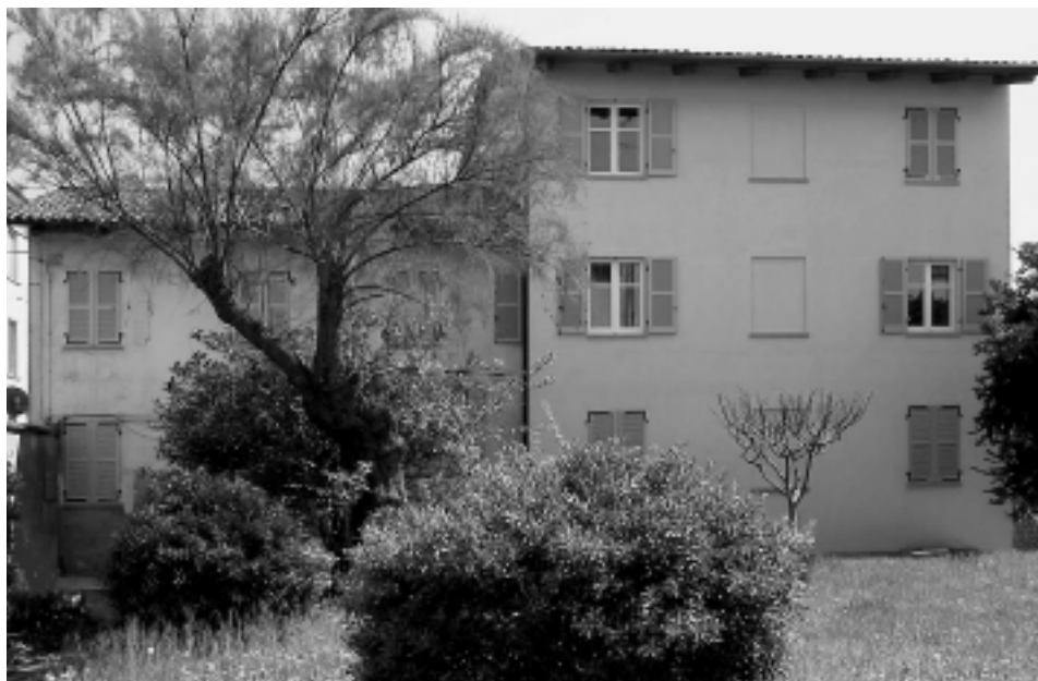
Museo Civico Craveri di Bra: ristrutturazione (a sinistra) e ampliamento (a destra) dei locali destinati agli uffici, al Laboratorio Territoriale di Educazione Ambientale e alla biblioteca multimediale.
